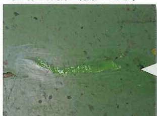
はみ出た材料を取り除き、ならして完成です。
