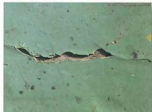
下地のゴミやホコリ・浮き塗膜など取り除き、十分に乾燥させます。
