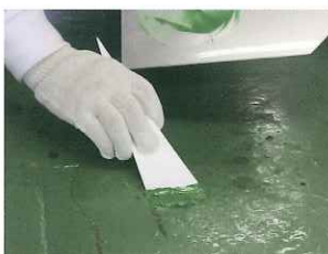
ゴムベラやパテベラ等で欠損部に塗り込んで修正します。
