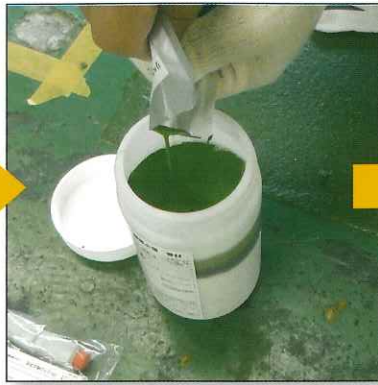
②骨材に主剤、硬化剤、硬化促進剤を投入します
