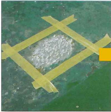
①施工箇所を養生します
