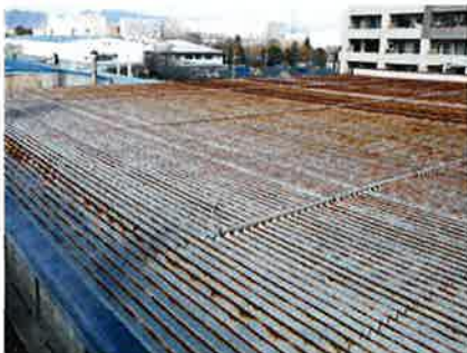
【倉庫屋根へのラバーロック全面施工例】
