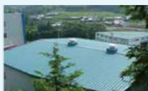
施工前の鋼板屋根
