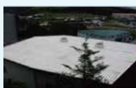
白の遮熱塗料+NFE2光触媒施工
